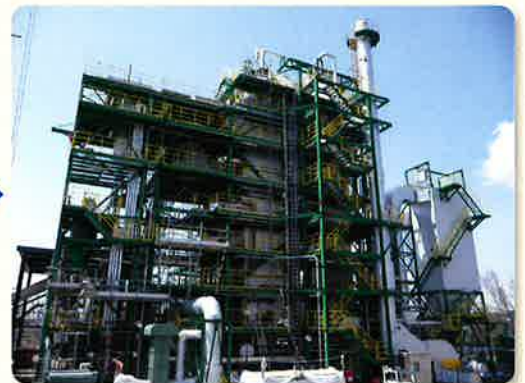
ボイラ据付完了
