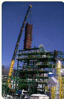
実際の据付風景
